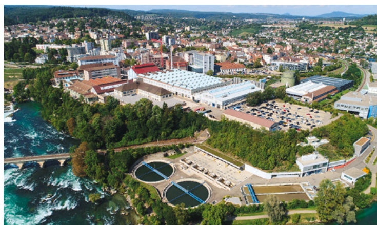
Im Vordergrund die ARA Röti, nördlich davon das Industriequartier mit der SIG. Der Energieverbund profitiert von den finanziellen Beiträgen aus dem CO 2 -Kompensationsprogramm Wärmeverbünde.
